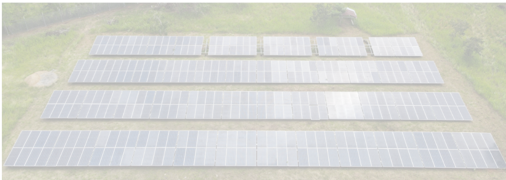
Area de Generación y Distribución.
