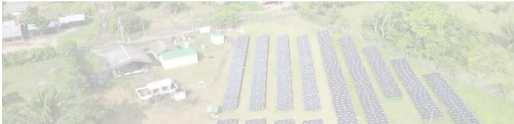
Area de Generación y Distribución.
